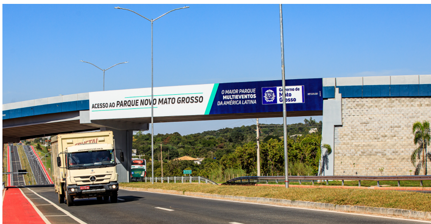
Fachada do viaduto de acesso ao Parque Novo Mato Grosso - "O maior Parque Multieventos da América Latina". Imagem registrada em 24.05.2023.
